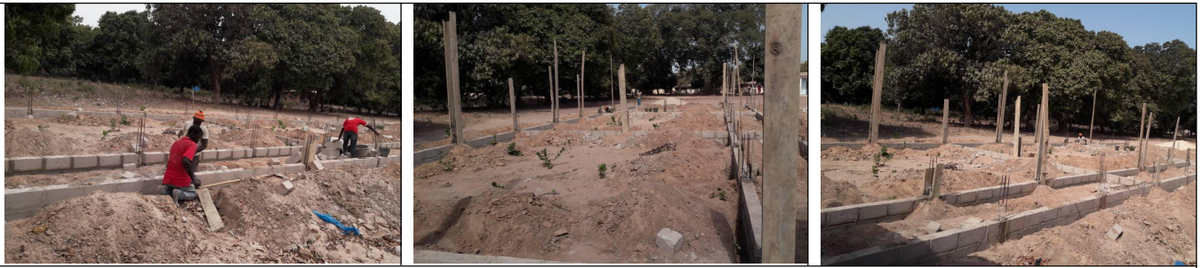
Als de fundering 3 bakstenen hoog is gemetseld wordt het vlechtwerk dat uitsteekt bekist en in beton gestort.
