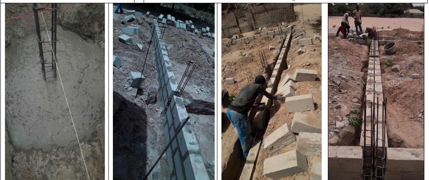
Daarna wordt het vlechtwerk op de hoeken en om de zoveel meter in het beton gestort. Daaromheen komt later een bekisting om betonnen palen te maken. Deze verankeren de muren. Voor de fundering zelf worden volle bakstenen gebruikt.
