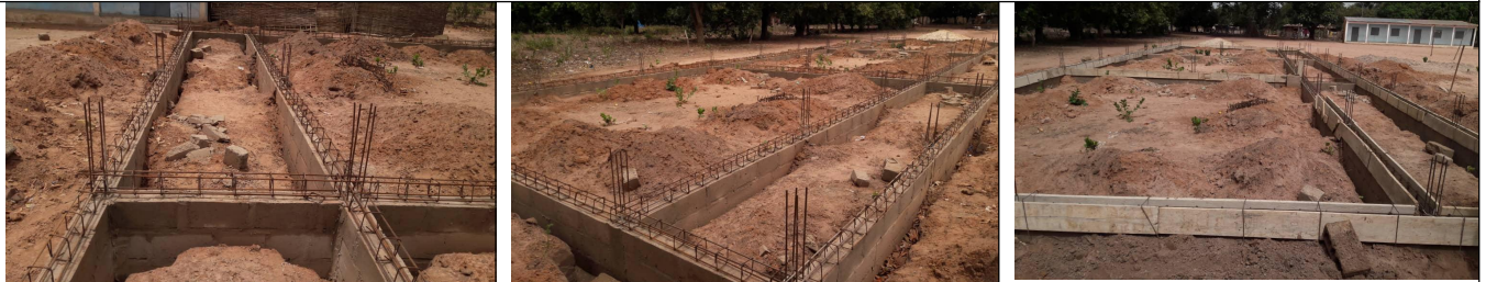
Op de gemetselde fundering komt over de hele omtrek opnieuw vlechtwerk met daarom heen een bekisting.
