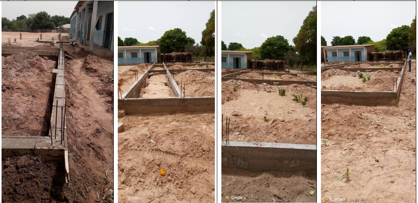
Deze wordt volgestort met beton. Als deze is verwijderd is de fundering klaar.
